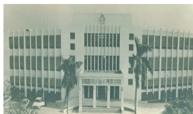
完工後前棟辦公大樓正面。（臺南高分檢署提供）
