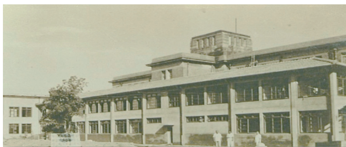
42 年增建辦公大樓施工狀況。（臺南高分檢署提供）
