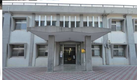
第二辦公室整修後全貌
